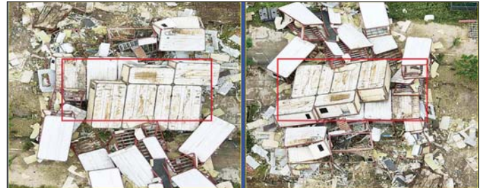
ကရင်ပြည်နယ် မြဝတီမြို့နယ် ရွှေကုက္ကိုလ်နယ်မြေရှိ အွန်လိုင်းလိမ်လည်လောင်းကစားမှုများ လုပ်ကိုင် ခဲ့သည့် တရားမဝင် ခြောက်ထပ်အဆောက်အအုံအား ယစ်ဖြင့် ဖောက်ခွဲဖျက်ဆီးပြီးစီးမှုကို တွေ့ရစဉ်။
