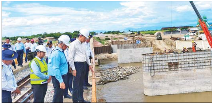
ရေနံနှင့် ဆက်သွယ်ရေးဝန်ကြီးဌာန ပြည်ထောင်စုဝန်ကြီး ဦးမြထွန်းဦးသည် ပို့ဆောင်ရေးဝန်ကြီးဌာန ဒုတိယဝန်ကြီး၊ တိုင်းဒေသကြီး စက်မှု၊ လျှပ်စစ်နှင့် လမ်းပန်းဆက်သွယ်ရေးဝန်ကြီးနှင့်အတူ ကြည့်ရှုစစ်ဆေးပြီး (အပေါ်ပုံ) တံတားတည်ဆောက်ရေး စီမံကိန်းရှင်းလင်းဆောင်၌ တာဝန်ရှိသူများနှင့် တွေ့ဆုံ၍ ချည်းကပ်ရထားလမ်းများအား တံတားနှင့်တစ်ပြိုင်တည်း ပြီးစီးရေးဆောင်ရွက်ရန် ချောင်းကမ်းပါးနံရံများ သတင်းစဉ်
