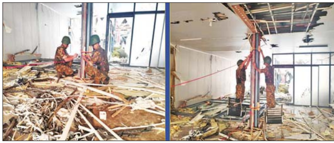
ကရင်ပြည်နယ် မြဝတီခရိုင် ရွှေကုက္ကိုလ်နယ်မြေရှိ အွန်လိုင်းလိမ်လည်လောင်းကစားမှု လုပ်ကိုင်ခဲ့သည့် တရားမဝင် ခုနစ်ထပ်လူနေအဆောက်အအုံအား ယမ်းဖြင့် ဖောက်ခွဲဖျက်ဆီးရန်ပြင်ဆင်နေမှုကို တွေ့ရစဉ်။
