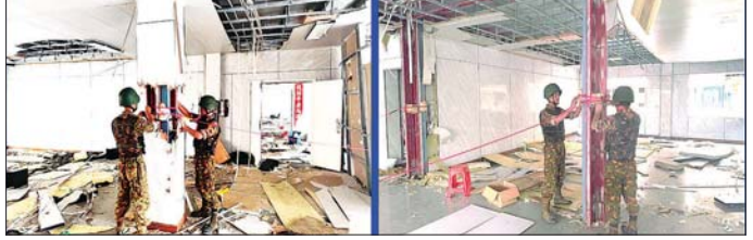
ကရင်ပြည်နယ် မြဝတီခရိုင် ရွှေကုက္ကိုလ်နယ်မြေရှိ အွန်လိုင်းလိမ်လည်လောင်းကစားမှုလုပ်ကိုင်ခဲ့သည့် တရားမဝင် ခုနစ်ထပ်လူနေအဆောက်အအုံအား ယမ်းဖြင့်ဖောက်ခွဲဖျက်ဆီးရန်ပြင်ဆင်နေမှုကို တွေ့ရစဉ်။
