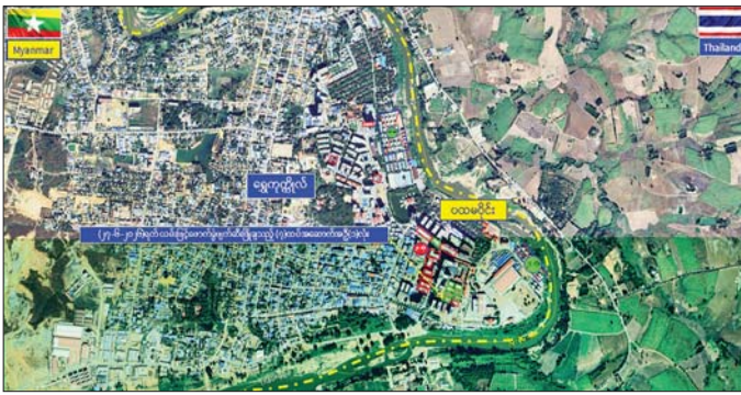
ကရင်ပြည်နယ် မြဝတီမြို့နယ် ရွှေကုက္ကိုလ်နယ်မြေရှိ အွန်လိုင်းလိမ်လည်လောင်းကစားမှုများ လုပ်ကိုင်ခဲ့သည့် တရားမဝင် အဆောက်အအုံများအား ဖောက်ခွဲဖျက်ဆီးမှုပြုပြင်ပုံ။
