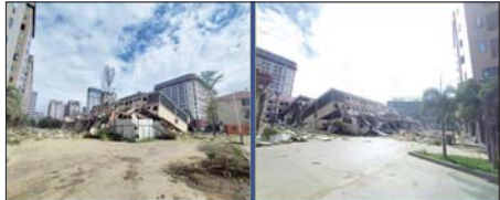
ကရင်ပြည်နယ် မြဝတီခရိုင် ရွှေကုက္ကိုလ်နယ်မြေရှိ အွန်လိုင်းလိမ်လည် လောင်းကစားမှု လုပ်ကိုင်ခဲ့သည့် တရားမဝင် ခုနစ်ထပ် လူနေ အဆောက်အအုံအား ယမ်းဖြင့်ဖောက်ခွဲဖျက်ဆီးပြီးမှု။
