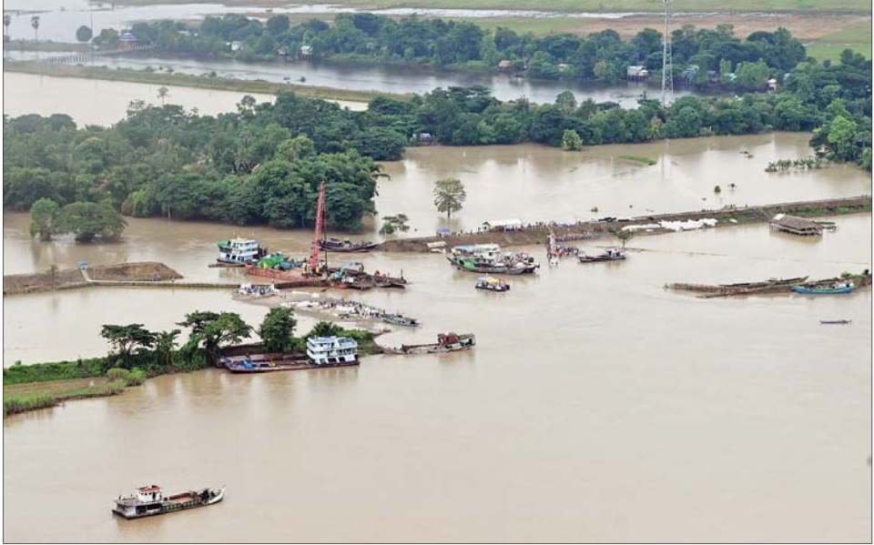
ငဝန်မြစ် ရေကာတာ တာတမံခံနိုင်ရည်ရှိမှုကြောင့် ရေတိုက်စားမှုကာကွယ်ခြင်းနှင့် ရေနက်ရေစီးကြောင်း ပိတ်ဆို့နိုင်ရေး လုပ်ငန်းဆောင်ရွက်နေမှုကို တွေ့ရစဉ်။
