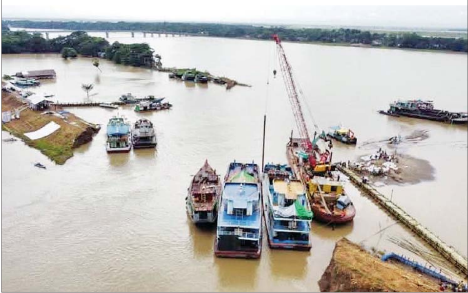
ငဝန်မြစ် ရေကာတာ တာတမံခံနိုင်ရည်ရှိမှုကြောင့် ရေတိုက်စားမှုကာကွယ်ခြင်းနှင့် ရေနက်ရေစီးကြောင်း ပိတ်ဆို့နိုင်ရေး လုပ်ငန်းဆောင်ရွက်နေမှုကို တွေ့ရစဉ်။
