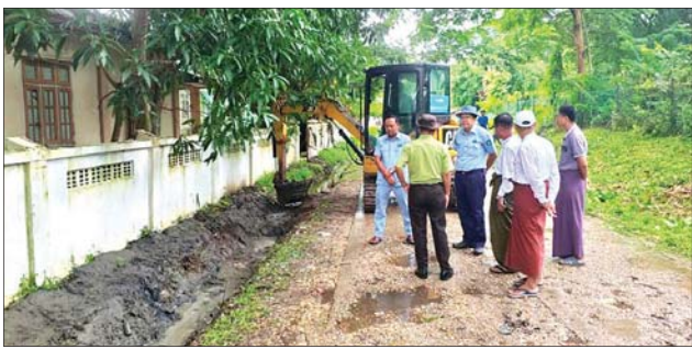
ကော်မတီဥက္ကဋ္ဌ ဦးကိုကိုလှိုင်၏ ကြီးကြပ်မှုဖြင့် စည်ပင်သာယာရေး အဖွဲ့ အမှုဆောင်အရာရှိ ဦးနေမျိုး အောင်က ဦးဆောင်၍ မြို့နယ် စည်ပင်သာယာရေးအဖွဲ့မှ ဝန်ထမ်း များက ရေနုတ်မြောင်းများ တူးဖော်
