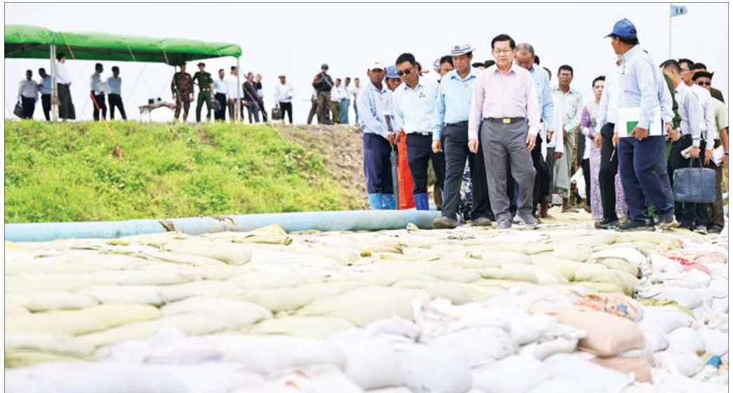
နိုင်ငံတော်သမ္မတ ဦးမင်းအောင်လှိုင် ဧရာဝတီတိုင်းဒေသကြီး ညောင်တုန်းမြို့နယ် ဂန့်ချောင်းကျေးရွာအနီး ညောင်တုန်းကျွန်းတာ(ဧရာဝတီမြစ်ခွဲ)တာကိုယ်ထည် ရေတိုက်စားခံရမှု ယာယီတားဆီးကာကွယ်ရေးလုပ်ငန်းများဆောင်ရွက်နေမှုများကို ကြည့်ရှုစစ်ဆေးစဉ်။
