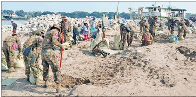
Geobags သဲအိတ်ကြီးများ ချခြင်း၊ မျောတုတ်တန်း များအတွင်း သဲအိတ်များ ဖြည့်၍ကာကွယ်ခြင်းနှင့် Steel Sheet Pile ရိုက်သွင်းခြင်းစသည့် ဝန်
