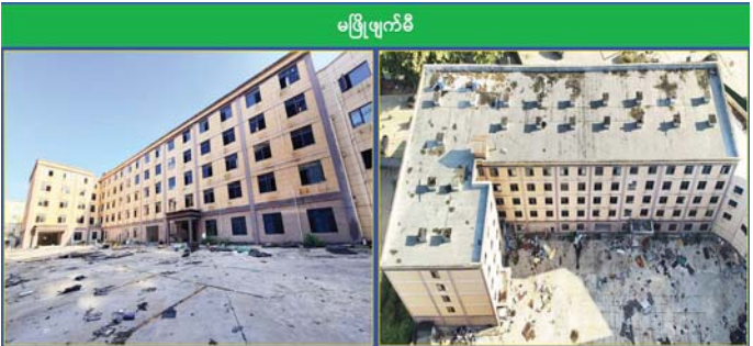
ရွှေကုက္ကိုလ်နယ်မြေ ဒုတိယပိုင်းအတွင်းရှိ အွန်လိုင်းလိမ်လည်လောင်းကစားမှုကျူးလွန်ရာတွင် အသုံးပြုသည့် တရားမဝင်အဆောက်အအုံများအား မဖြိုချဖျက်ဆီးမီနှင့် စနစ်တကျဆက်လက်ဖြိုချဖျက်ဆီးစဉ်။
