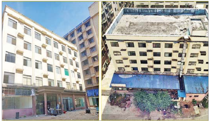
ရွှေကုက္ကိုလ်နယ်မြေ ဒုတိယပိုင်းအတွင်းရှိ အွန်လိုင်းလောင်းကစားမှုကျူးလွန်ရာတွင်အသုံးပြုသည့် ၅ ထပ်အဆောက်အအုံများအား မဖြိုချမီ တွေ့ရစဉ်။
