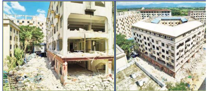
ရွှေကုက္ကိုလ်ဒေသ တရားမဝင်အွန်လိုင်းလောင်းကစားလုပ်ငန်းလုပ်ကိုင်ခဲ့သည့် ၆ ထပ်အဆောက်အအုံ အား ယန္တရားဖြင့် ဖြိုချဖျက်ဆီးမှုကို အောက်တိုဘာ ၂၈ ရက်က တွေ့ရစဉ်။
